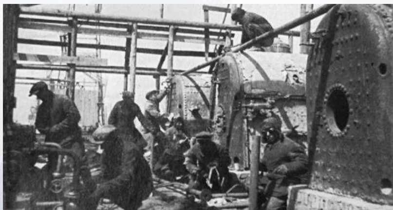
Монтаж оборудования на Сызранском нефтеперерабатывающем заводе
